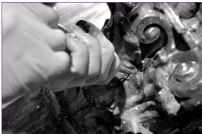
Consolidación con resina epoxi de una fisura estructural en el capitel de una columna.
